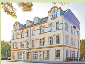
Wohnhaus Rathenow Holzfenster in verschiedenen Sonderformen
