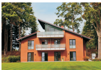
Einfamilienhaus Rheinsberg Kunststofffenster, Sonnenschutz, Innentüren, Einbauten, Garagentore
