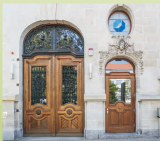
Restauration / Neubau Haustür
